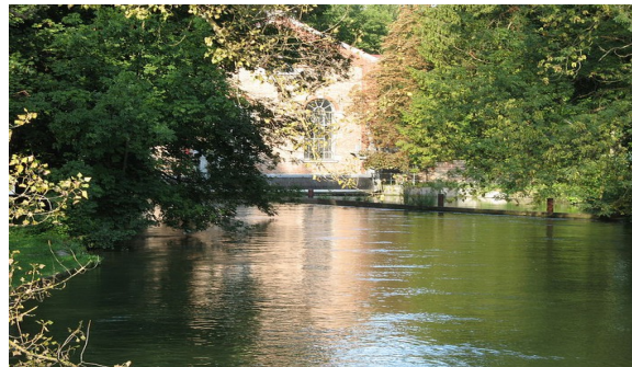
Tivoli Kraftwerk am Eisbach
